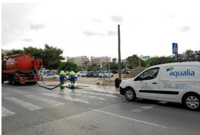
Operarios de Aqualia trabajando en la reparación de una tubería de la red de distribución de agua en Ibiza | Foto: Archivo
